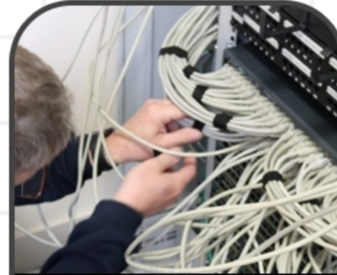
Instalasi Jaringan & Wifi
